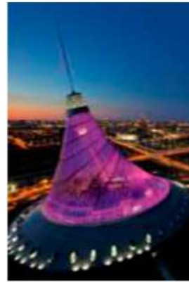
Рисунок 13 – Башня в Астане, Казахстан
